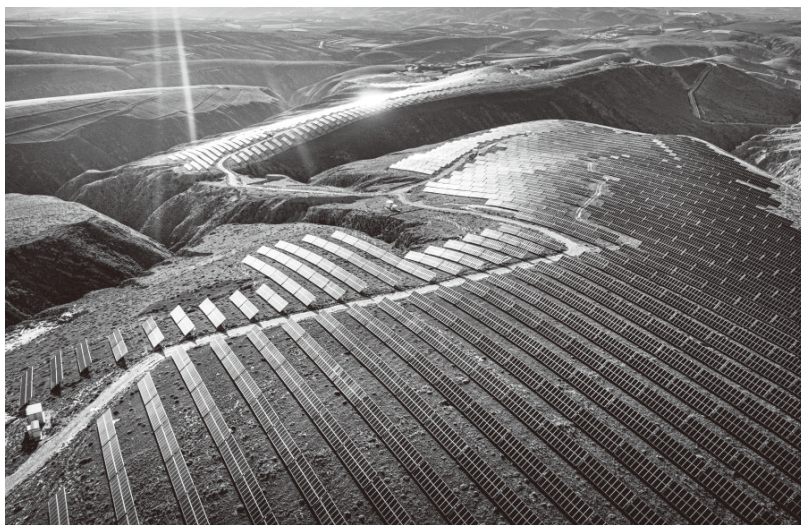
▲环县甜水镇扶贫光伏发电项目并网发电
